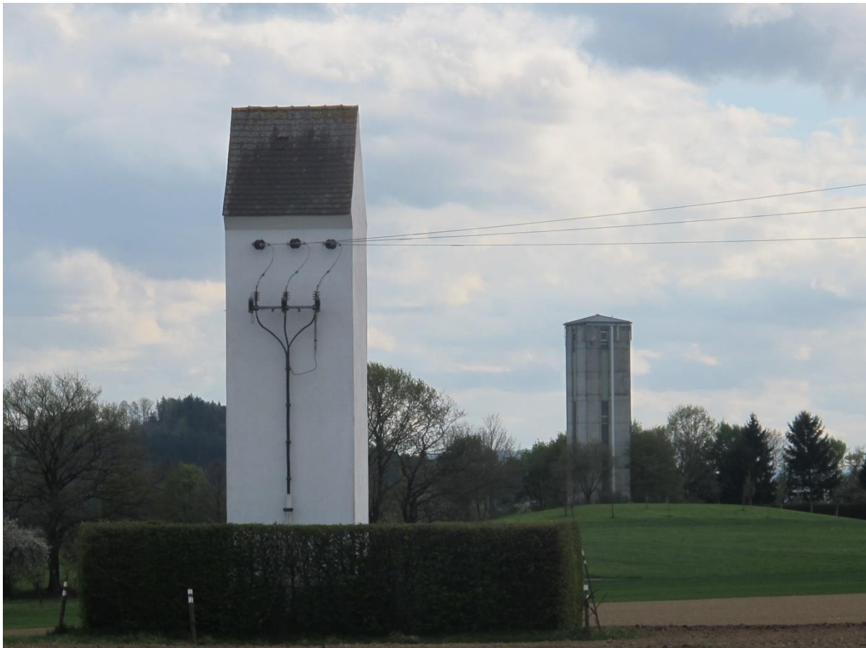
Wasserturm und ehemaliges Transformatorenhäusle, 2014
