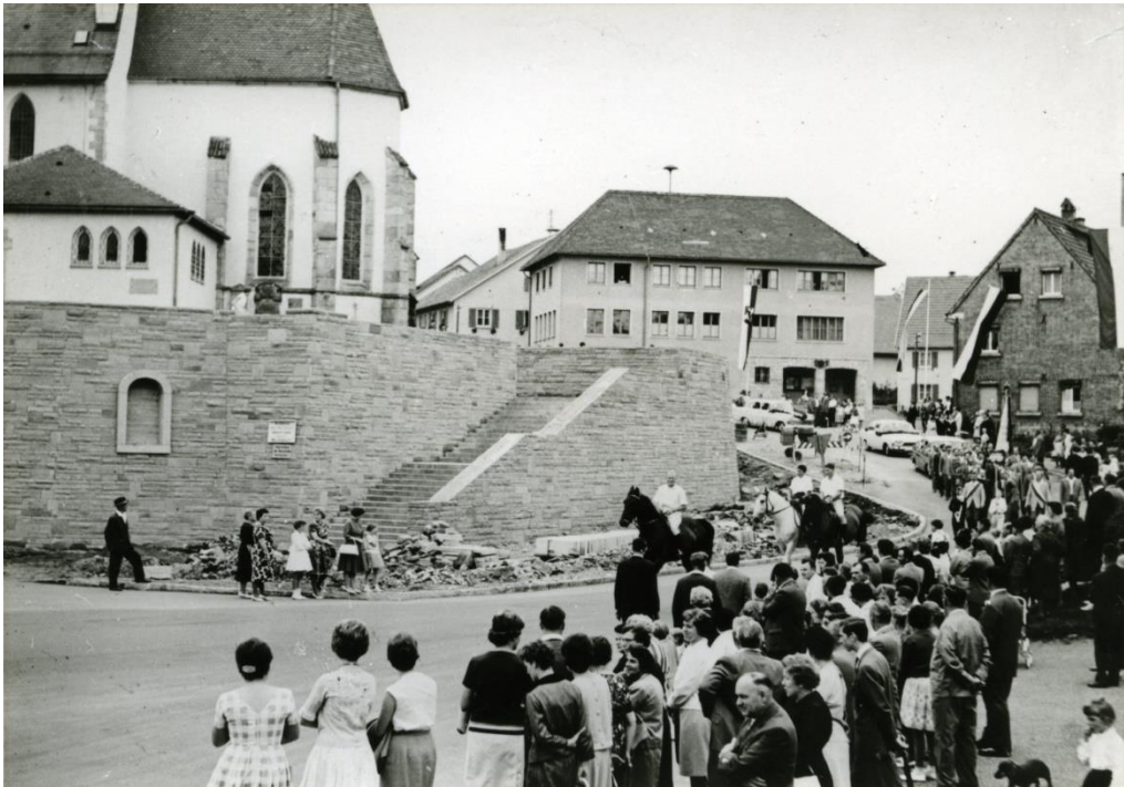
Die Kirchenmauer ist fertig, vermutlich 1963
