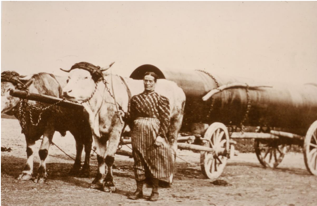
Transport der Rohre
