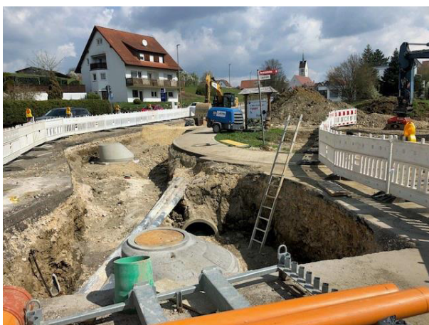
Neuer Edeka - Kanalarbeiten
