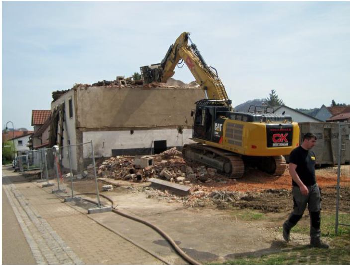
Abbruch Gebäude Heubeundstr. 19
