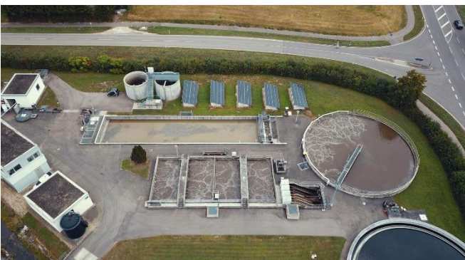
Neue PV-Anlage auf der Verbandskläranlage
